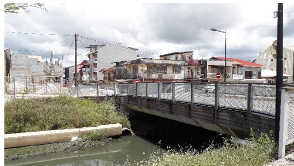
Canal Laussat – Eaux stagnantes
